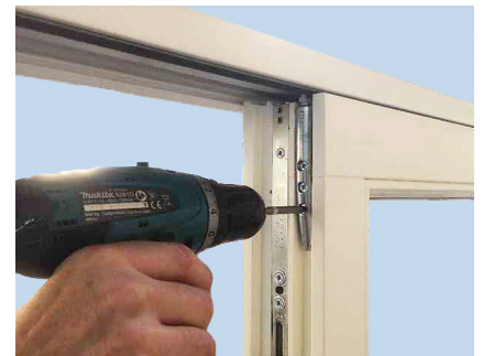
Kuvat 2 ja 3. Peitelistan irrottaminen.
