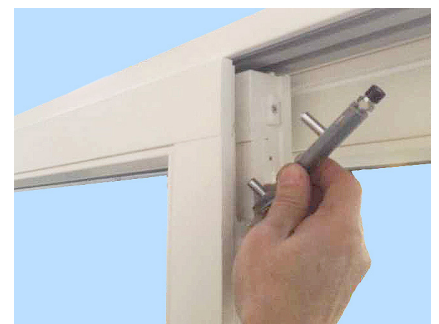
Kuvat 4 ja 5. Liukupultin irrottaminen.
